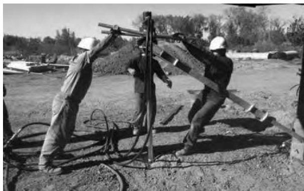
Рис. 1. Завинчивание свай средствами малой механизации
